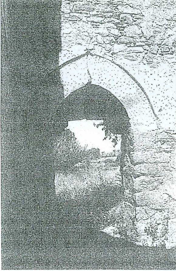
RESİM 5: Edirne-Uzunköprü-Kırkavak Köyü Gazi Turhan Bey Camii, girişinin içten görünümü.
